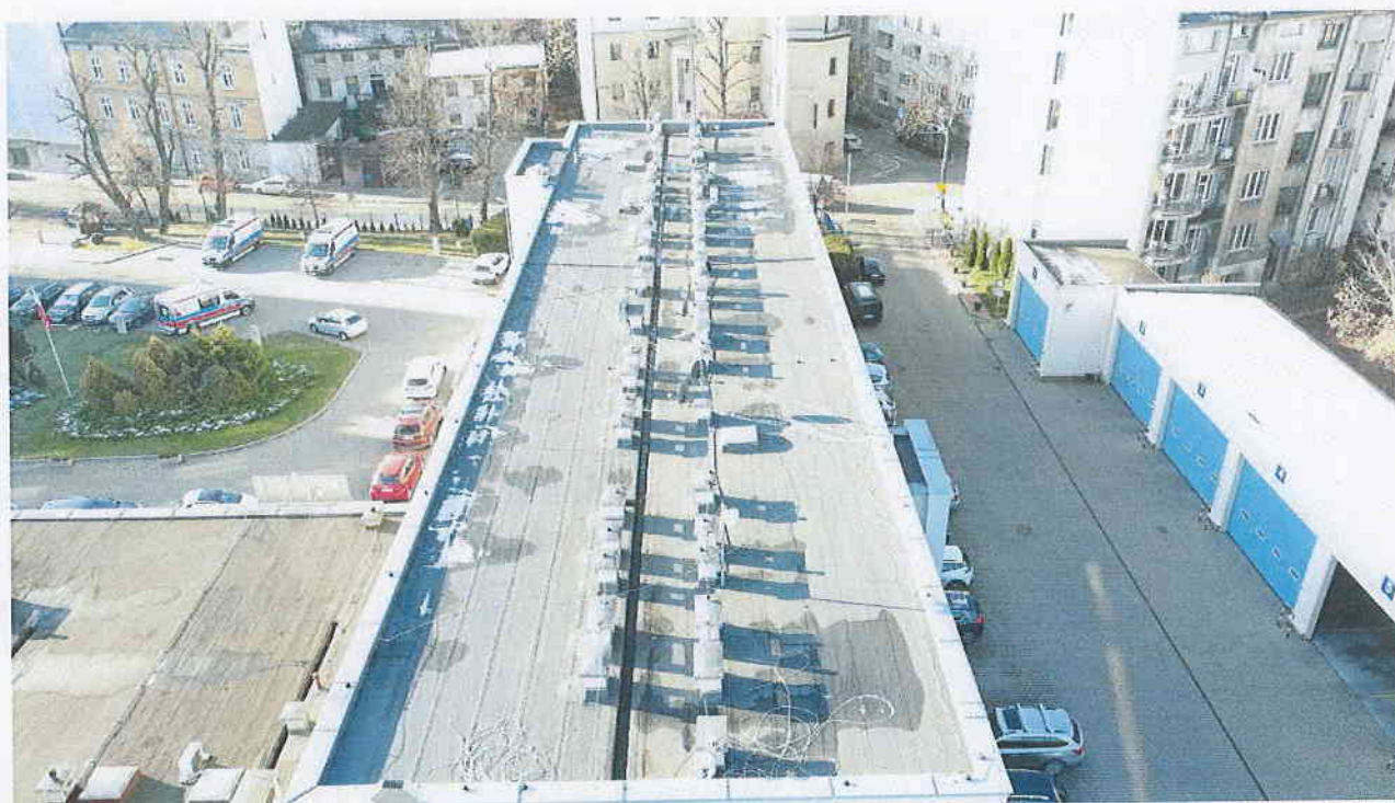
Widok pokrycia dachowego – zdjęcie poglądowe
